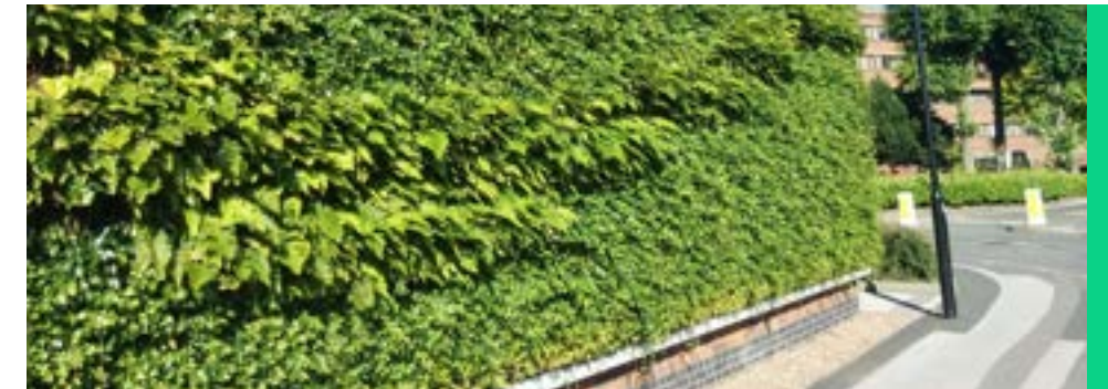
Enhance blank façades
